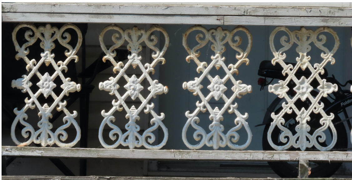
Détail du garde-corps en fonte, à motifs en losange et arabesques au 270 à 288, rue Saint-Jean-Baptiste, Nicolet. Source : Bergeron Gagnon inc., été 2024.
