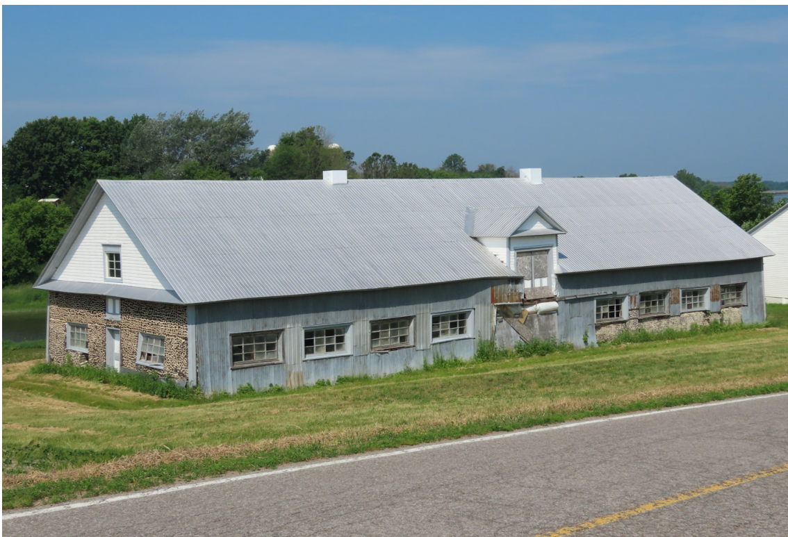
L'ancienne porcherie de l'ensemble de ferme du Séminaire de Nicolet. 1600, rang de l'Île, Nicolet. Source : Bergeron Gagnon inc., été 2024.
