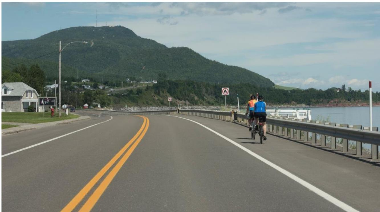
Figure 25 : Accotement asphalté
