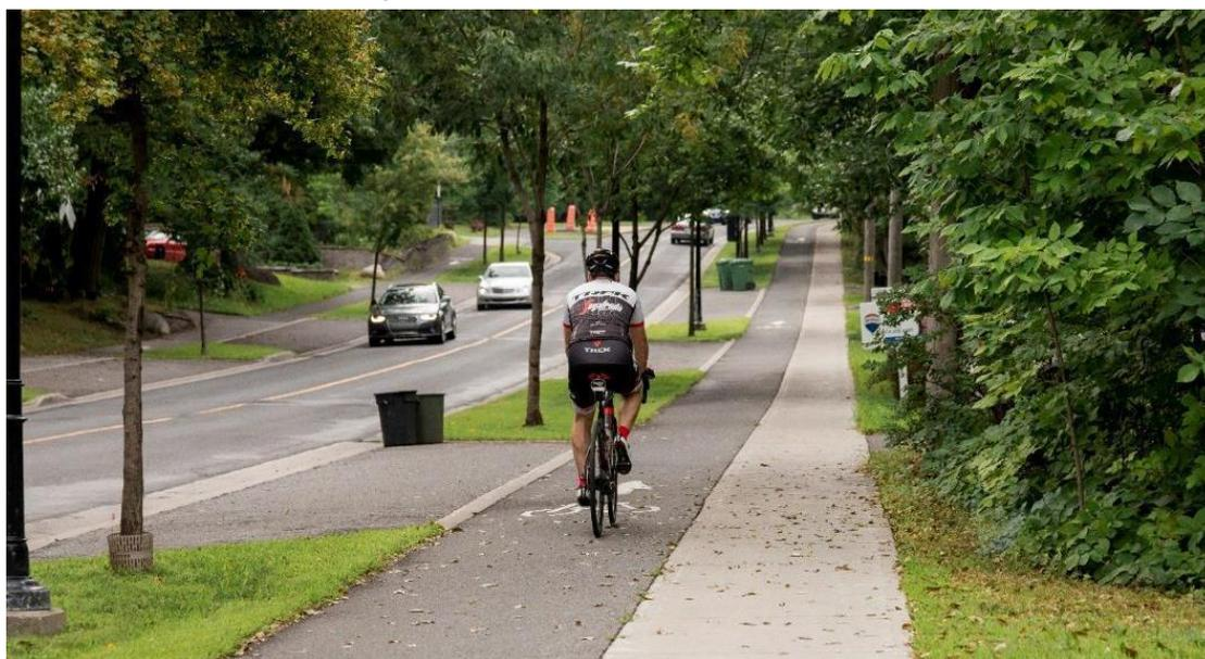
Figure 23 : Piste cyclable unidirectionnelle au niveau du trottoir
